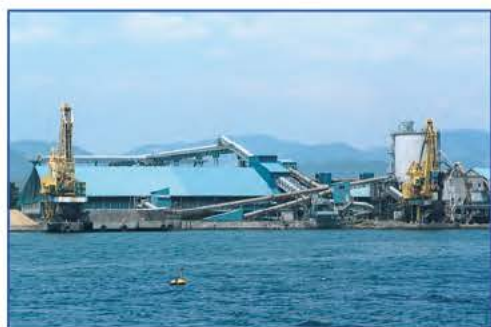
石炭荷揚げ搬送コンベア設備
