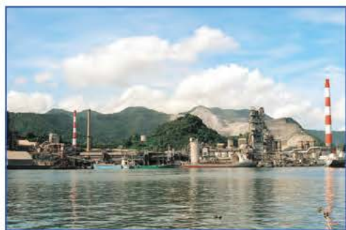
受入・船積み設備
