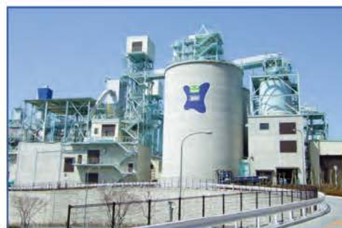
エコセメント製造設備
