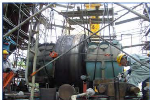
キルン支持装置改修
