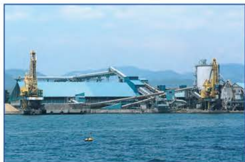
石炭荷揚げ搬送コンベア設備
