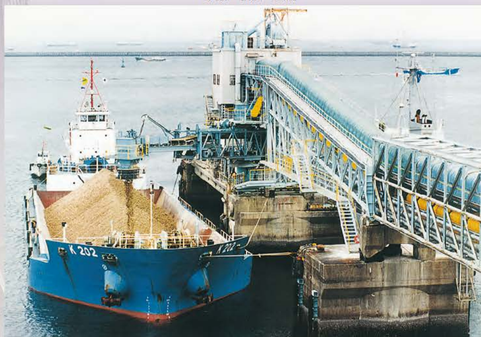
土砂搬送船積み設備
