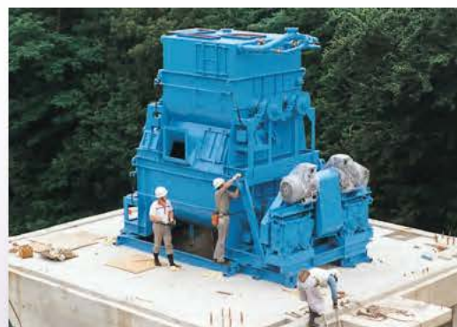
生コンプラントミキサー据付け工事
